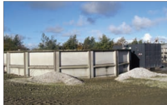
Fra tanken i forgrunden hentes gylle til gårdens biogasanlæg, mens tanken bagved modtager den afgassede gylle. Foto: Troels Grønbæk.
